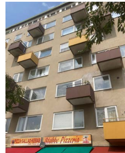
Detalj av husets fasad mot torget.
