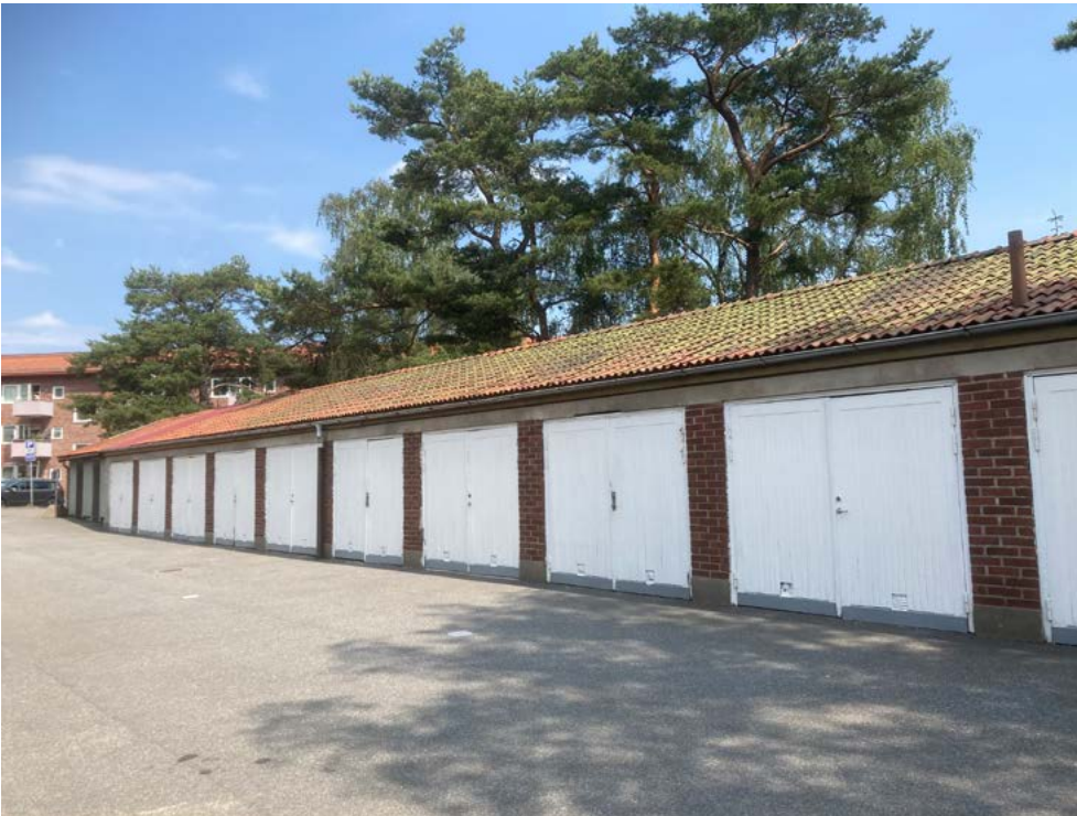
Garagebyggnad med fasad i rött tegel och ursprungliga garageportar.
