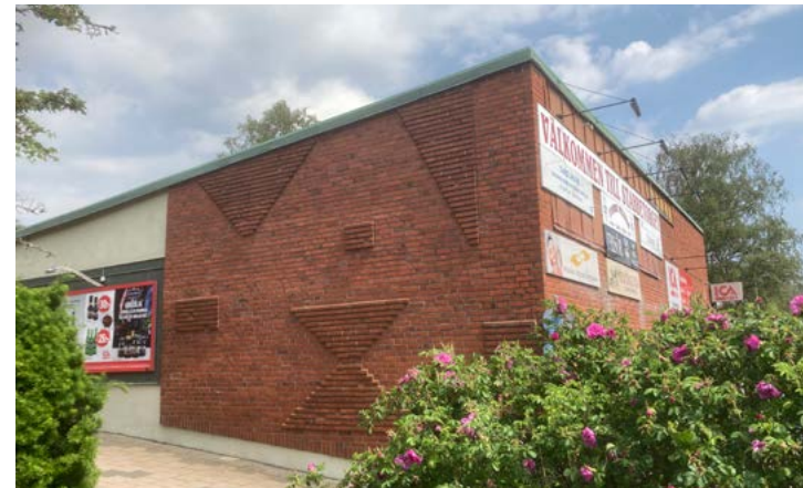
Butikshuset avslutas söderut med en individuellt utformad del i tegel med geometriserande mönstermurning. Det in mot torget sluttande pulpettak kompletterar de diagonala formerna i fasaden. Avtäckning av kopparplåt knyter samman byggnaden till en helhet.
