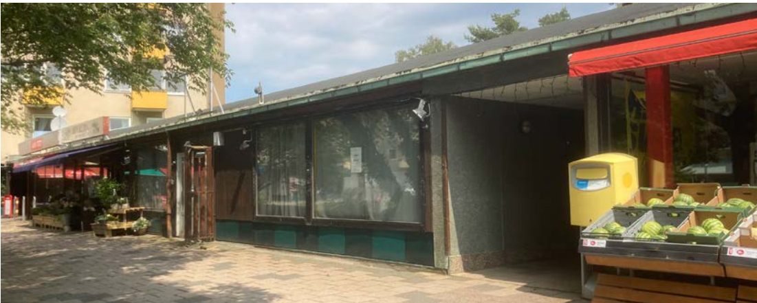
Butikshusets framsida mot torget. Det rundade taket, avtäckningarna i kopparplåt, de stora, välkomnande fönsterpartierna och bröstningar av grön/blå "dura-front" utgör värdebärande karaktärsdrag.
