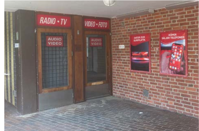
Inskjutning i butikslängan med golv av klinker och entréparti i oljad teak. Dörrarna har omfattande glasing och karaktäristisk sparkplåt.
