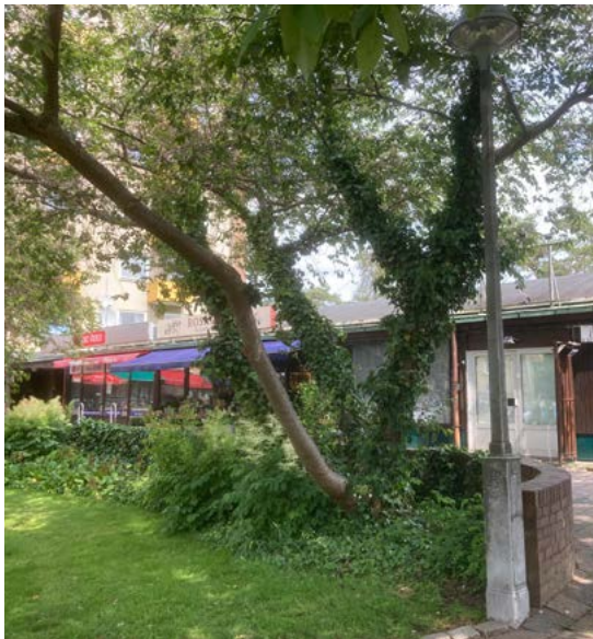
Belysningsstolpar kring torget finns kvar i original och är av den typ som togs fram till jubileumsutställningen 1923. Stolparna kring Stabbetorget kännetecknas av en kantig form med bredare bas dekorerad med en sol. Lamphuset är senare utbytt och var ursprungligen globformat.
