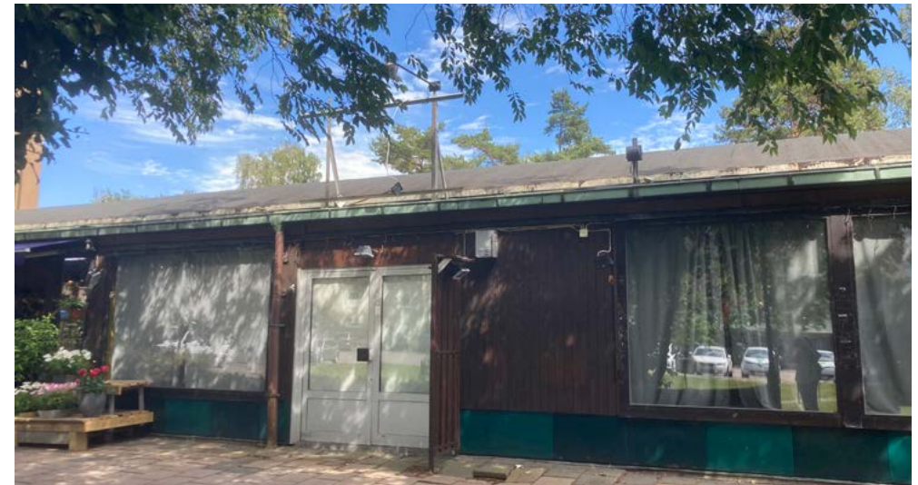
Affärshuset har kvar de öppna butiksfönstren (ofta är bågarna tilläggsisolerade med plåt och mellanpartierna med träpanel) med ursprunglig sockel av plåt ("dura-fronter").
